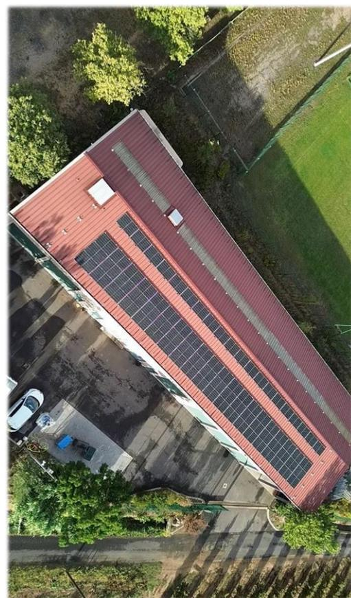
Le **toit des ateliers municipaux** vient d'être équipé de 80 modules photovoltaïques couvrant une superficie de 160 m<sup>2</sup>. Cet investissement assurera en autoconsommation les besoins des bâtiments communaux en journée et permettra de réduire la dépense en électricité. L'éventuel surplus sera envoyé dans le réseau.
