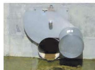
Le comportement hydraulique d'une vanne à flotteur n'est pas décrit par une formule mathématique. Le concepteur du bassin de rétention devra par conséquent se référer aux indications du fabricant (tables, abaques etc.) pour le choix du régulateur.
