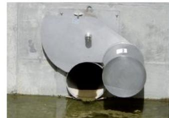
Le comportement hydraulique d'une vanne à flotteur n'est pas décrit par une formule mathématique. Le concepteur du bassin de rétention devra par conséquent se référer aux indications du fabricant (tables, abaques etc.) pour le choix du régulateur.
