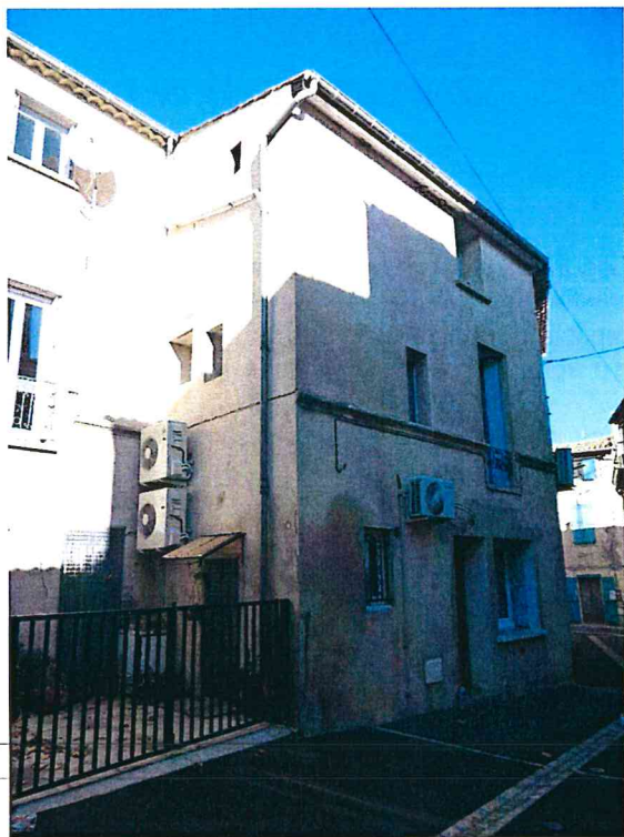
Contraste entre deux attitudes : négligence de la façade avec pose de climatiseurs, gouttières en PVC et enduit ciment
