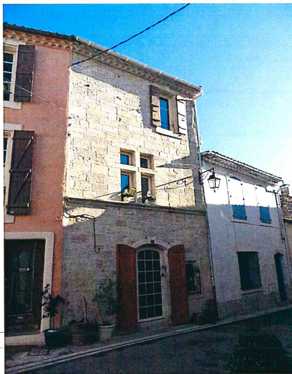
restauration et valorisation d'une façade appareillée
